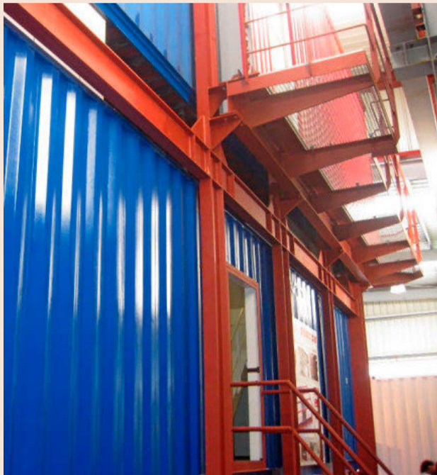
Gabadi también ha construido módulos habitacionales para buques.
